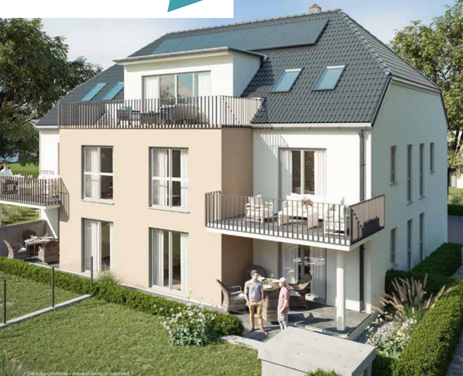
Darstellungsbeispiel – Bauausführung abweichend
